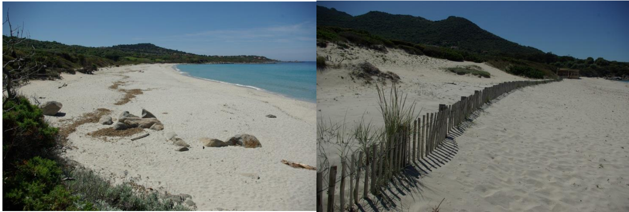
Illustration 42 – Plages de Corbara : Absence de protection du haut de plage à l'ouest (à gauche) alors qu'à l'est un dispositif a été mis en place pour limiter la détérioration de la dune de haut de plage (à droite)
