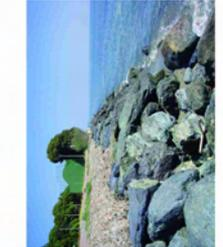
**Coupe 10 :** Elle se situe au niveau d'une zone aménagée. Une digue en enrochements protège les enjeux en arrière. Une banquette de positionnés surplombe les enrochements, signe de l'exclusion potentielle des vagues lors des tempêtes.
